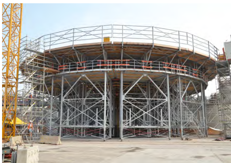
Spezialentwicklung von ROBUSTA-GAUKEL für Stuttgart 21 im Ersteinsatz: Die komplett eingeschaltete Unterrüstung für den ersten Randkelch. (Quelle: ROBUSTA-GAUKEL)
