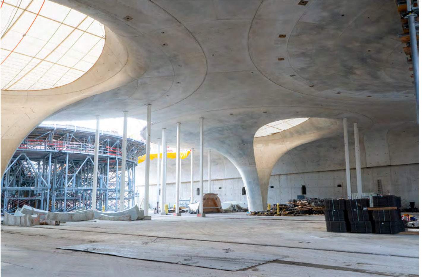
Die imposante Architektur von Stuttgart 21: Schwindgassen, die Deckenfelder zwischen den Kelchen, verbinden die unterschiedlichen Kelchformen miteinander. (Quelle: DB/Malte Hombergs)
